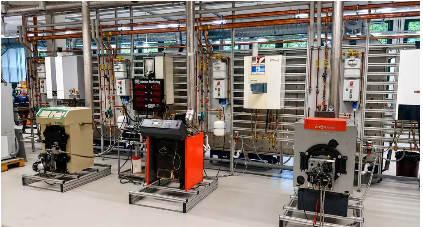
Kombinierter Arbeitsplatz mit Energieversorgung und Energieentsorgungssäule für Wärmeerzeuger in Wand- und Standausführung
